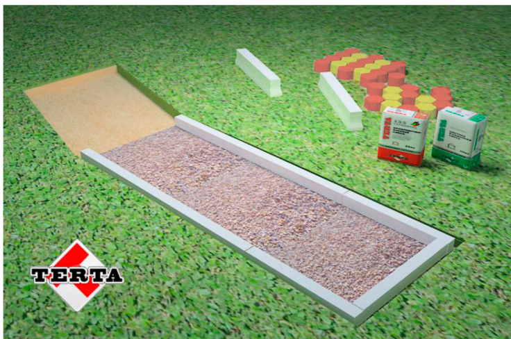
засыпка песчано-гравийного слоя и установка бордюрного камня
